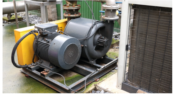
Bild 3: Nahansicht des sechsstufigen Gebläses von Continental Industrie
