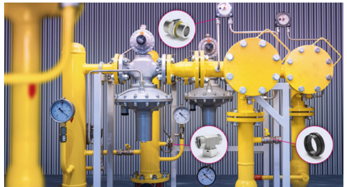
Bild 1: Bauteile für die stationäre Gasdruckregel- und Messanlagen (GDRM-Anlagen)
