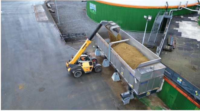
Bild 2: Das Eintragsystem zur Befütterung der Maissilage mit einem Fassungsvermögen von 60 t
