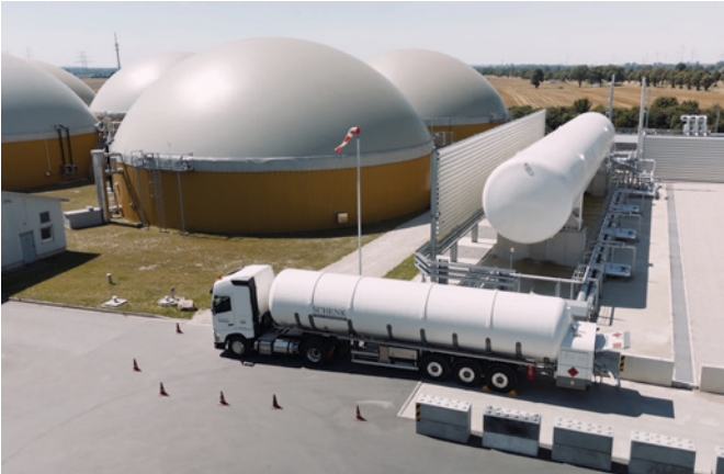
Bio-LNG ab Werk: Direkt auf dem Gelände produziert und in Tanklastwagen verladen – für die Versorgung grüner Tankstellen
