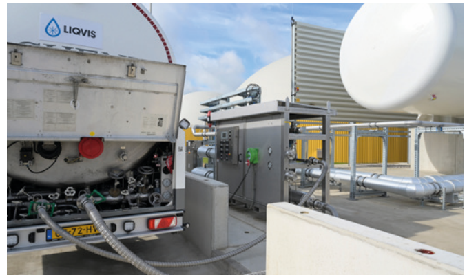
Quelle: EnviTec Biogas
