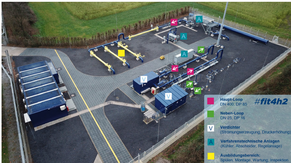
Bild 1: Aufbau der H 2 -Trainingsstrecke (Aufnahme vom 07.08.2024)
