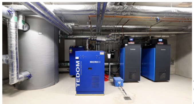
Bild 2: Ein Blockheizkraftwerk ist zentraler Bestandteil des Konzepts „Sichere Energieversorgung kritischer Infrastrukturen“ – kurz SEKI
