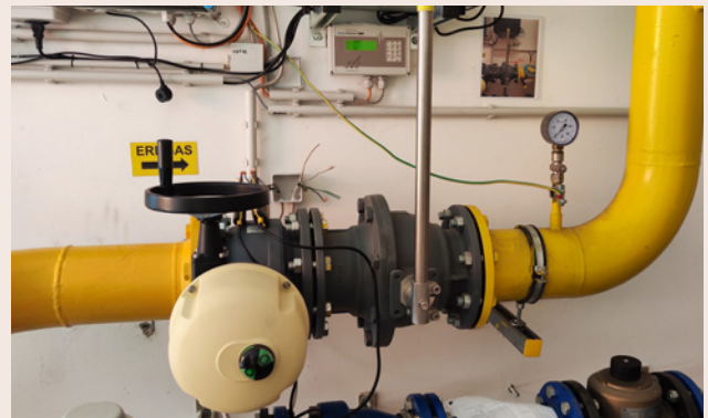
Erdbebenschutz für Gasanlagen
