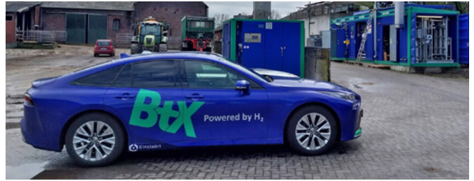
Anlage zur Erzeugung von 100 kg/d Wasserstoff in BZ-Qualität in Krefeld
