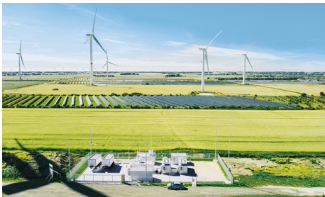
Bild 1: H-TEC SYSTEMS PEM-Elektrolyseure im Einsatz im schleswig-holsteinischen Bosbüll, unweit von Ellhöft und Westre. Ein ME450 PEM Elektrolyseur kann pro Tag 450 kg grünen Wasserstoff produzieren
