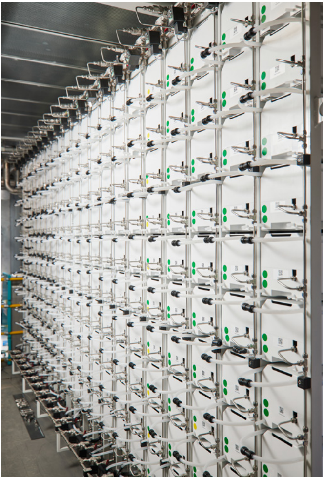
Bild 1: Die modularen AEM-Elektrolyseure können zu Strings kombiniert werden
