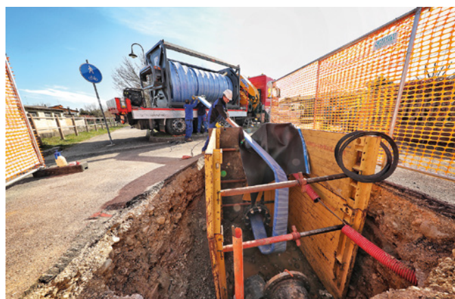
Bild 3: Mit Primus Line® lassen sich Einzugsängen von bis zu 2.500 m in einem Abschnitt realisieren
