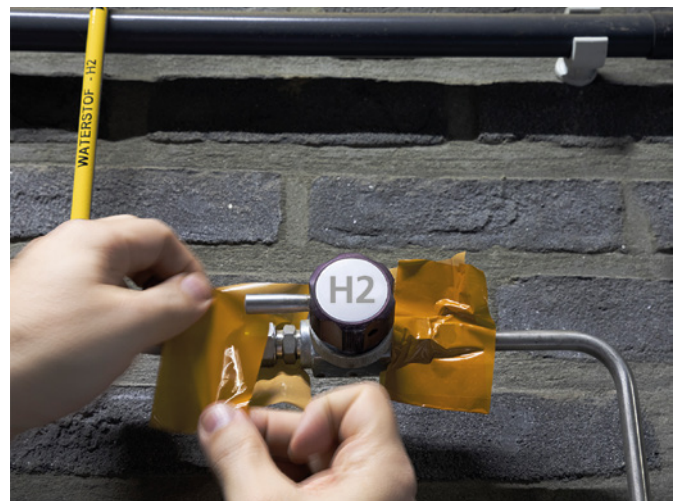
Bild 3: Die sogenannte „Butterfly Wrap“ Methode empfiehlt sich in schwierigen Bereichen
