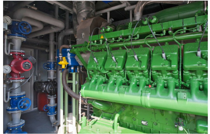
Biogasanlage am Randkanal-Nord, Motor des Blockheizkraftwerks (BHKW)
