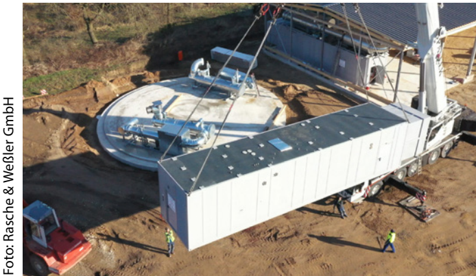
Bild 1: Containeranlieferung für das BHKW in Alfhausen
