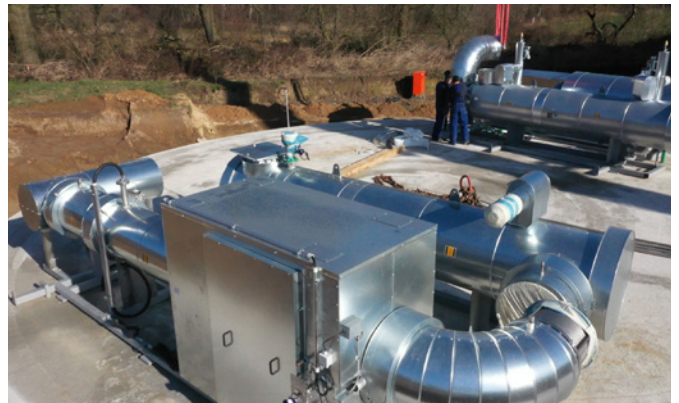
Bild 2: SCR-Katalysator und Abgaswärmetauscher vor der Installation auf den BHKW-Containern
