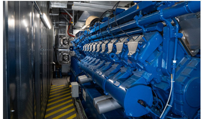
Bild 3: Zwei MWM TCG 3020 V20 Gasaggregate treiben das BHKW des Alfhausener Fernwärmenetzes an
