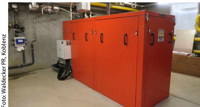
Bild 1: Das BHKW ELW 50-100 von Remeha ist für die Grundversorgung des Wohnquartiers zuständig
