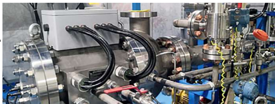
Bild 1: Gasdruckregelstation inklusive Entspannungsturbine
