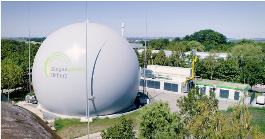
Die Biogas-Aufbereitungsanlage in Bitburg
