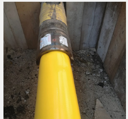
Bild 3 und 4: Mit Druckluft wird der Liner in seine runde Form gebracht
