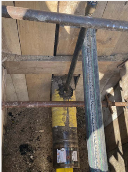
Bild 1: Einzug des Primus Liners durch mehrere 45-Grad-Bögen
