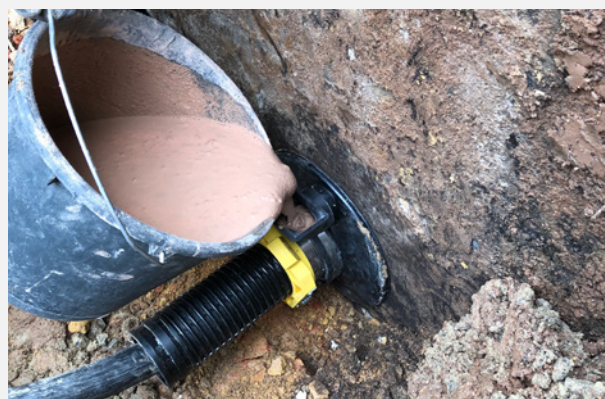
Bild 2: Segmentdichtung, durch Heraustrennen der Segmente kann jeder Leitungsdurchmesser im angegebenen Bereich abgedichtet werden
