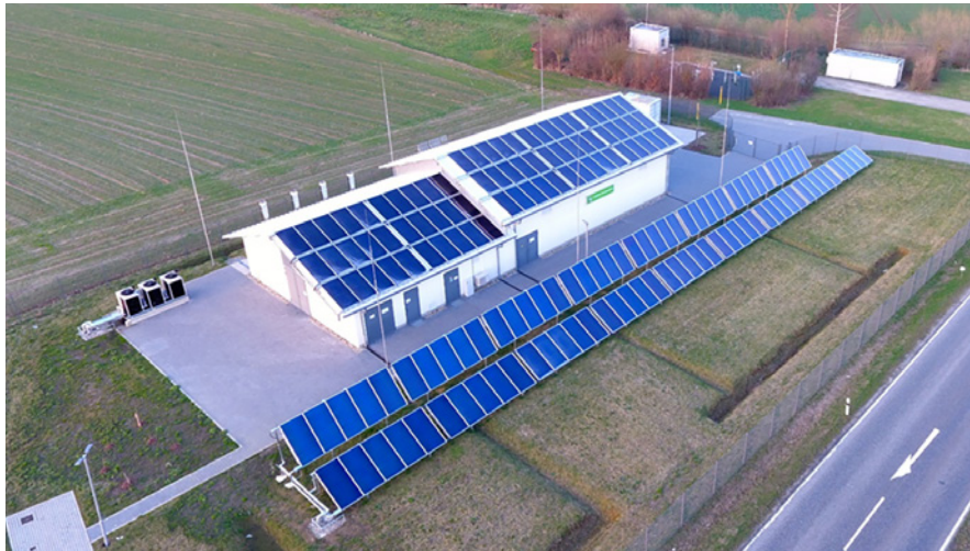
Bild 1: Luftbildaufnahme der GDRMA Ostheim, mit den solaren Kollektoren auf dem Feld und auf dem Dach sowie die drei gasbetriebenen Absorptionswärmepumpen (mittig-links)
